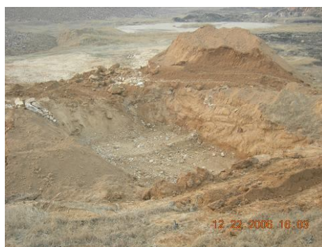
图4 3 # 现场试坑回填后的底层废石(土)
