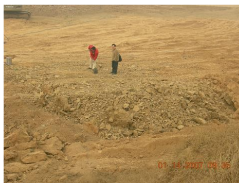
图5 回填完毕的3 # 现场试坑图
